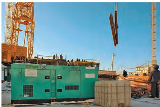
Строительство школы, РСУ-37
