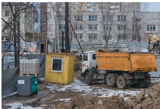
Строительство 16-ти этажного жилого дома. Строительство ведет ООО «Гранд-Строй»
